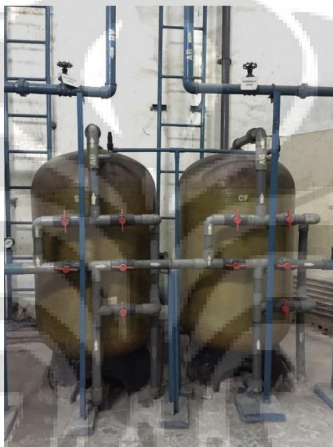
Gambar 4. 5 *Sand Filter* dan *Carbon Filter*
