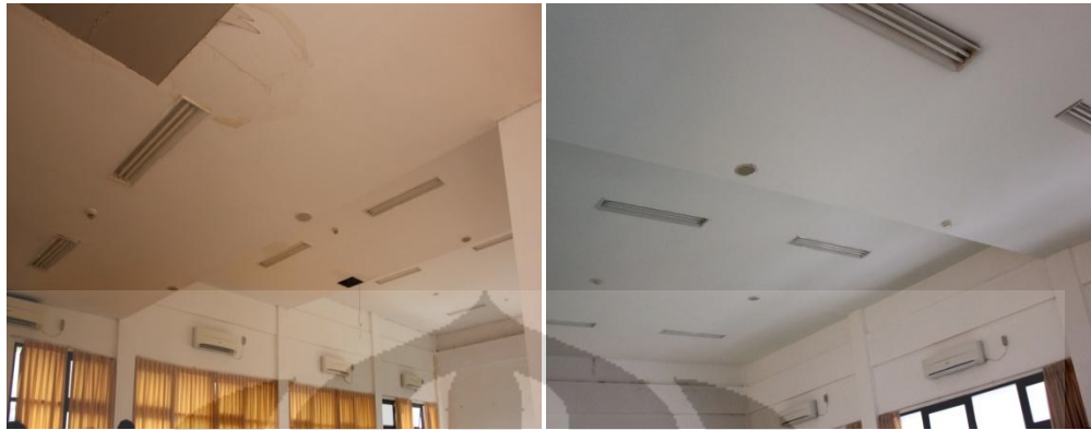
Gambar 6.33. Detektor Asap dan Speaker di Ruang SerbaGuna
