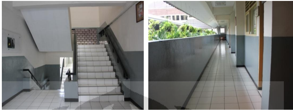
Gambar 6.58. Tangga Bagian Barat (Kiri) dan Koridor (Kanan) Lantai 2 Gedung Selatan Sekolah
