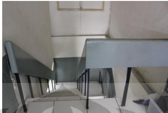
Gambar 6.56. Tangga Gedung Bagian Tengah Sekolah
