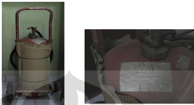
Gambar 6.4. APAR Gerak di Laboratorium Kimia
