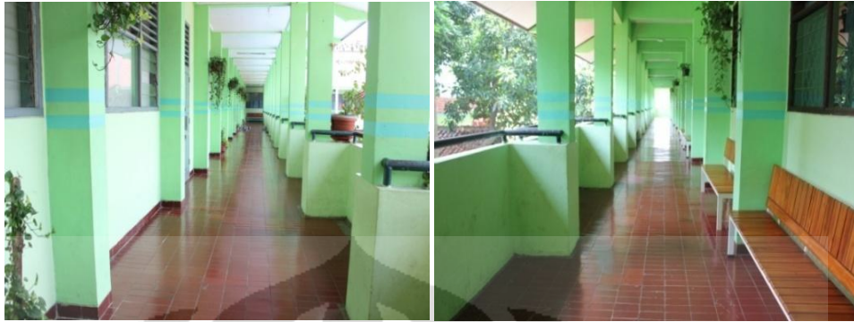
Gambar 6.14. Koridor Lantai 2 Gedung Barat Sekolah
