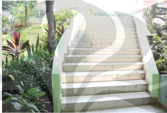
Gambar 6.18. Tangga Gedung Bagian Timur Sekolah
