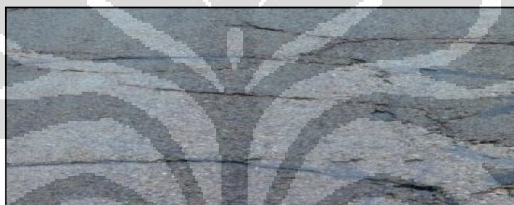
Gambar 2.5 Retak Susut
