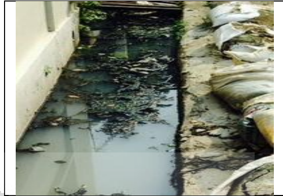
Drainase Kondisi Sedang
