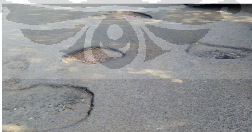
Gambar 2.8 Kerusakan Lubang
