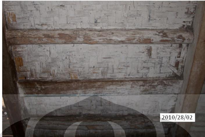
**Gambar 3.13** Gambar Struktur Dinding Dimana Balok Horizontal dan Vertikal Sebagai Struktur Utama
