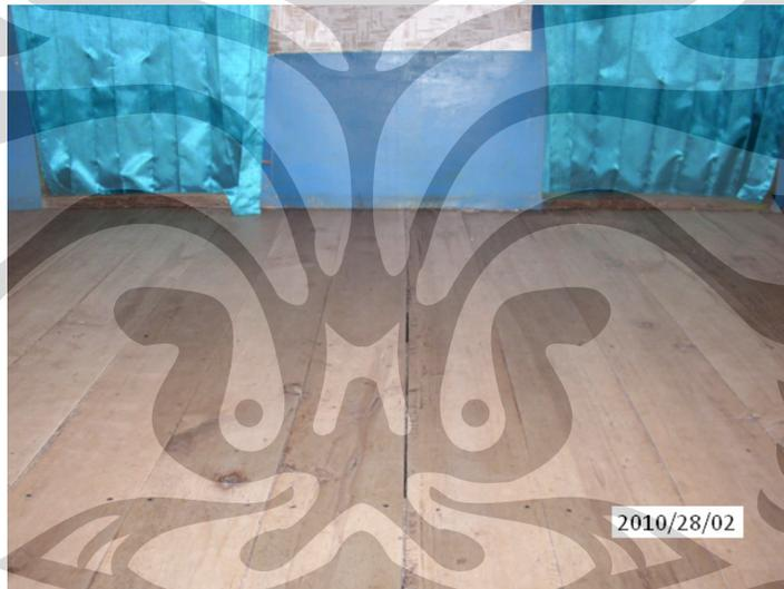
**Gambar 3. 15** Gambar Bagian Atas Struktur Lantai Rumah Kayu
