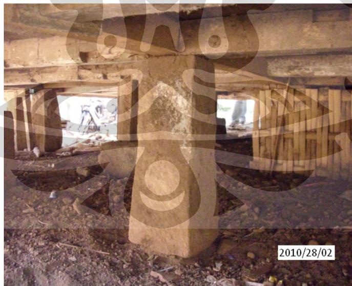
**Gambar 3. 17** Gambar Umpak Sebagai Struktur Pondasi Rumah Kayu
