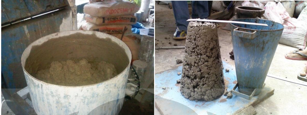
Pengadukan dan Pengukuran Slump
