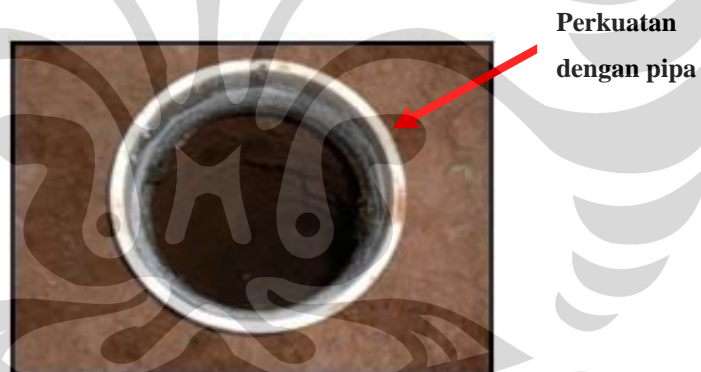
Gambar 4.3 Perkuatan mulut lubang resapan dengan pipa
