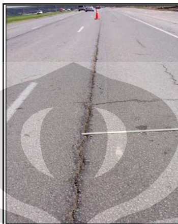
Gambar 2.19. Longitudinal cracking
