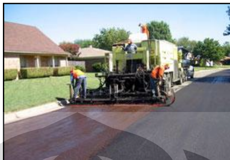
Gambar 2.32. Aplikasi slurry seal
