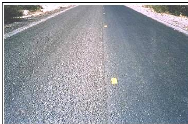
Gambar 2.31. Pengaplikasian fog seal pada perkerasan Bagian kiri (sebelum) dan kanan (sesudah)
