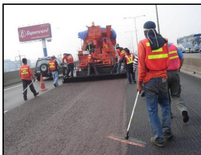
Gambar 2.33. Aplikasi micro-surfacing
