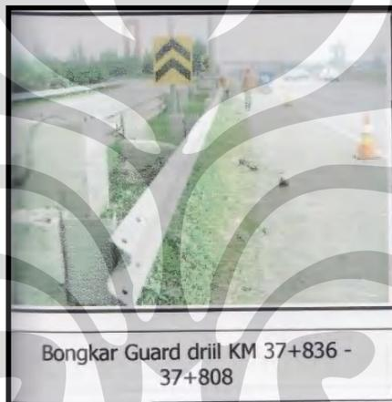
Gambar 4.6 Salah Satu kegiatan Pembongkaran Yang Dilakukan; Pembongkaran Guard Rail
