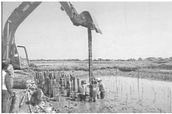
(a) Pemasangan Cerucuk Bambu
