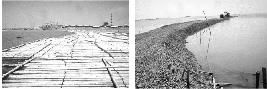
Gambar 2.24. Perkuatan cerucuk matras bambu yang digunakan dalam pembangunan embankment dike pada tambak Lorok Out Fall Channel sepanjang 1 km di PLTGU tambak Lorok, Semarang (Irysam, 1996).
