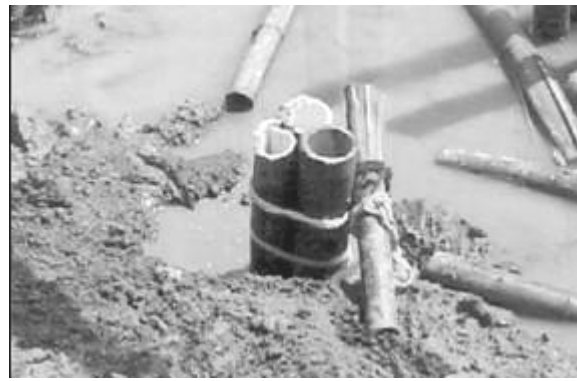
(b) Ikatan 3 Bambu untuk Struktur Cerucuk
