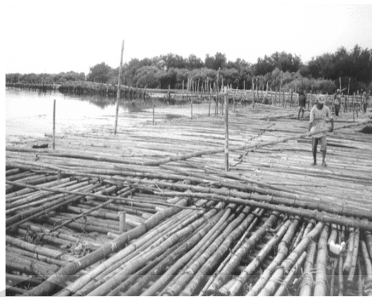
(b) Pemasangan matras bambu
