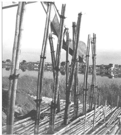
(a) Pemasangan cerucuk bambu
