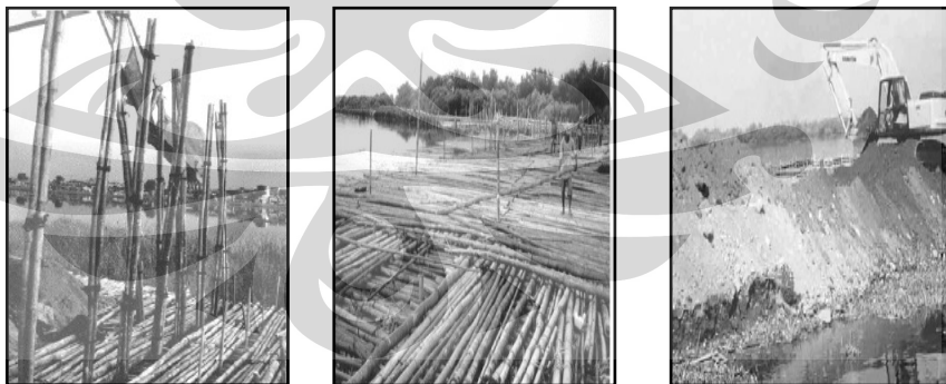
Gambar 2.25. Perkuatan cerucuk matras bambu yang digunakan untuk timbunan struktur Palisade pada bangunan pengendali banjir di Boezem Morokrempangan, Surabaya (Irysam, 2000).
