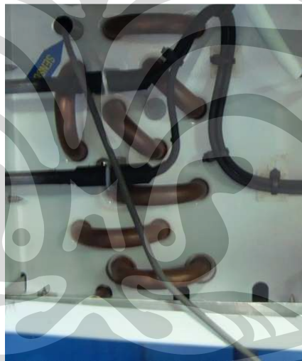
Gambar 3.47. Thermocouple pada tiupan Evaporator
