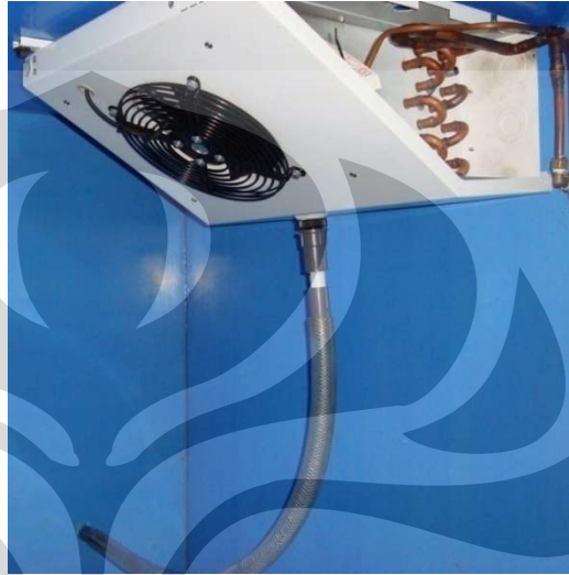
Gambar 3.8. Evaporator dengan kemampuan pendinginan yang kecil
