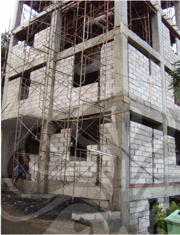
Gambar 3 Asrama putri sedang dalam proses pembangunan
