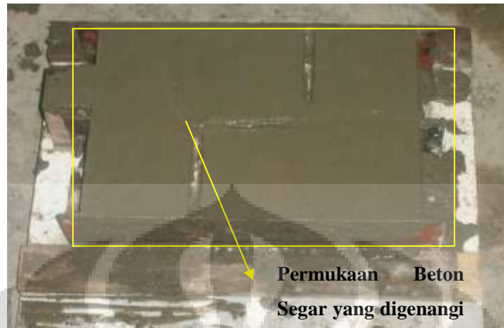
Gambar 39 : Bleeding Pada Beton Segar
