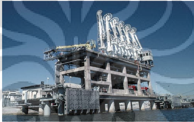
Gambar 2.5 LNG unloading arm platform
