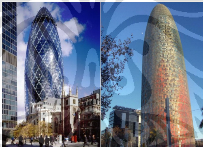
Gambar 2. "The Gherkin" atau Swiss Re Tower (kiri) dan "The Geyser" atau Agbar Tower (kanan) memiliki bentuk mirip sebagai respon aerodinamisasi pada bangunan pencakar langit. 77
