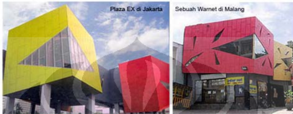
Gambar 1. Bagunan Plaza EX di Jalan M.H. Thamrin di Jakarta (kiri) yang serupa tapi tak sama dengan bangunan warnet di Malang (kanan). 76
