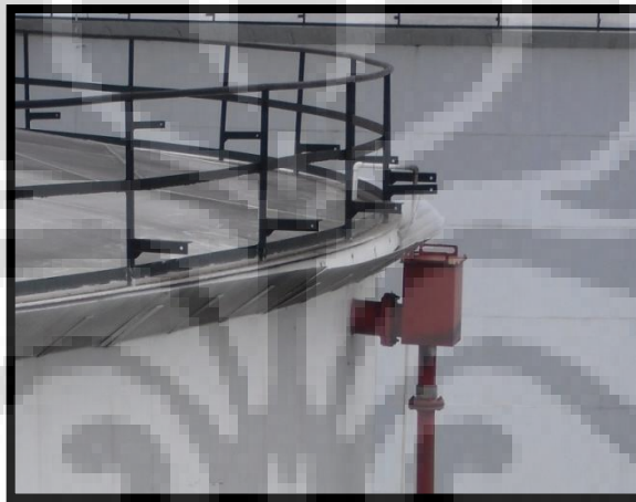
Gambar 5.9 Foam Chamber pada tangki timbun
