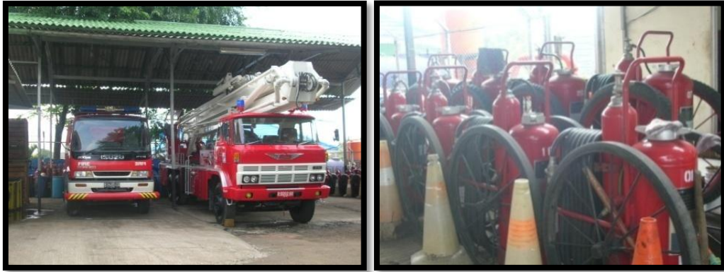
Gambar 5.18 Fasilitas penanggulangan kebakaran dan ledakan
