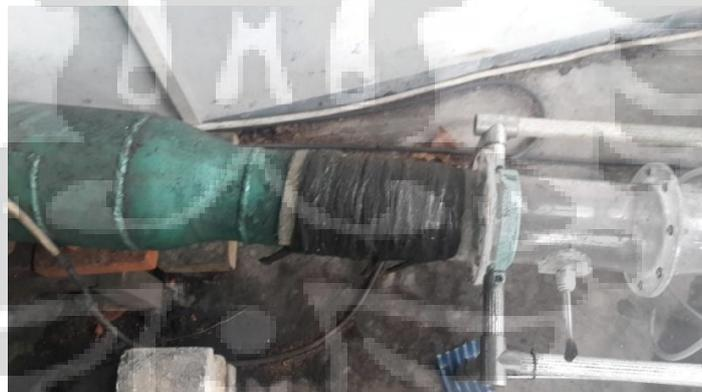
Gambar 3.5. Penyambungan Venturimeter dengan mixing chamber
