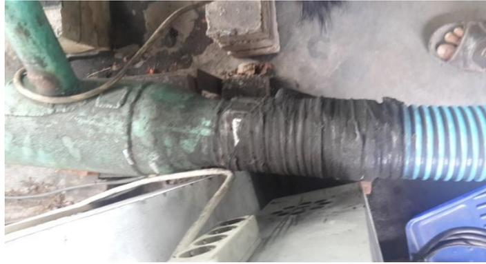
*Gambar 3.1. Penyambungan Pipa Fleksibel dengan Mixing Chamber*
