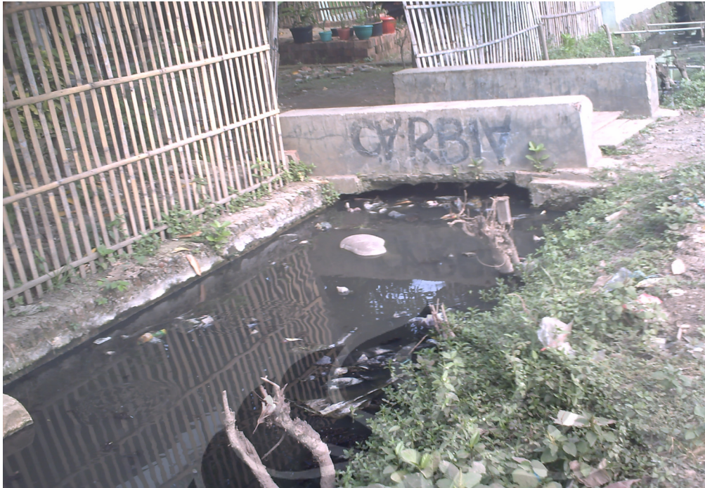
Gambar 3.8: Kondisi selokan air/saluran pembuangan air rumah tangga di Desa Lombang Sumber : Dokumentasi Pribadi (Hasil Olahan Sendiri)
