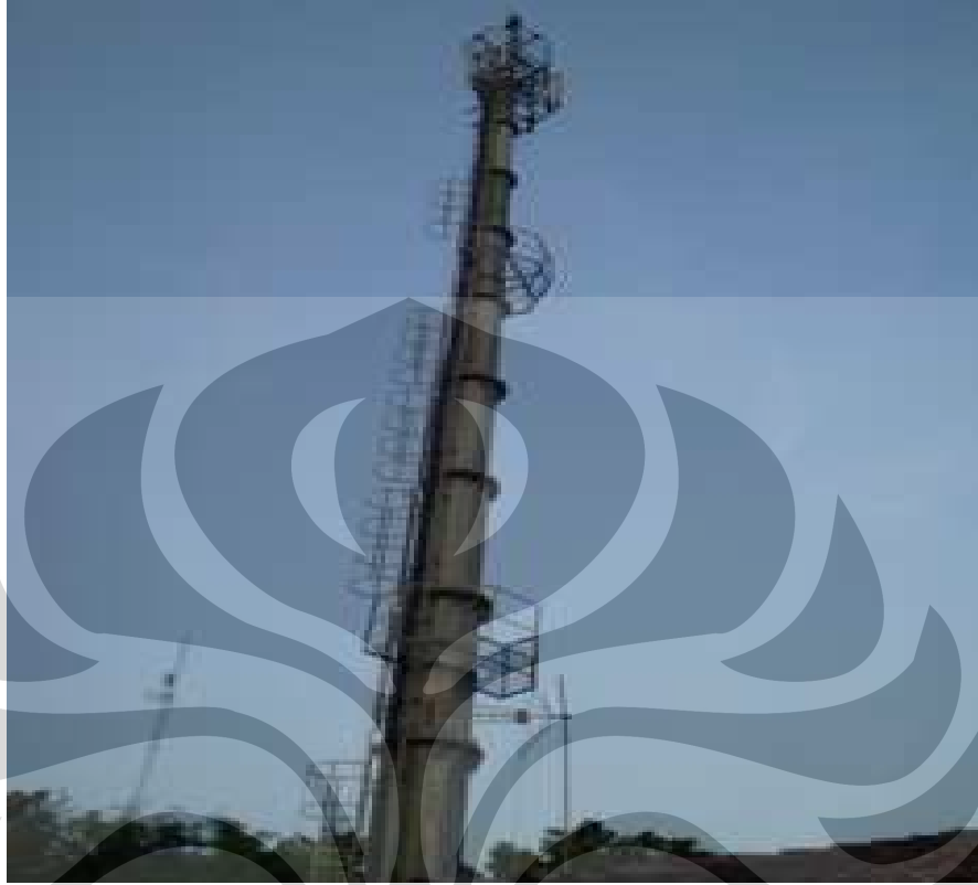
Foto 3. Menara BTS Tipe Monopole berada di atas permukaan tanah
