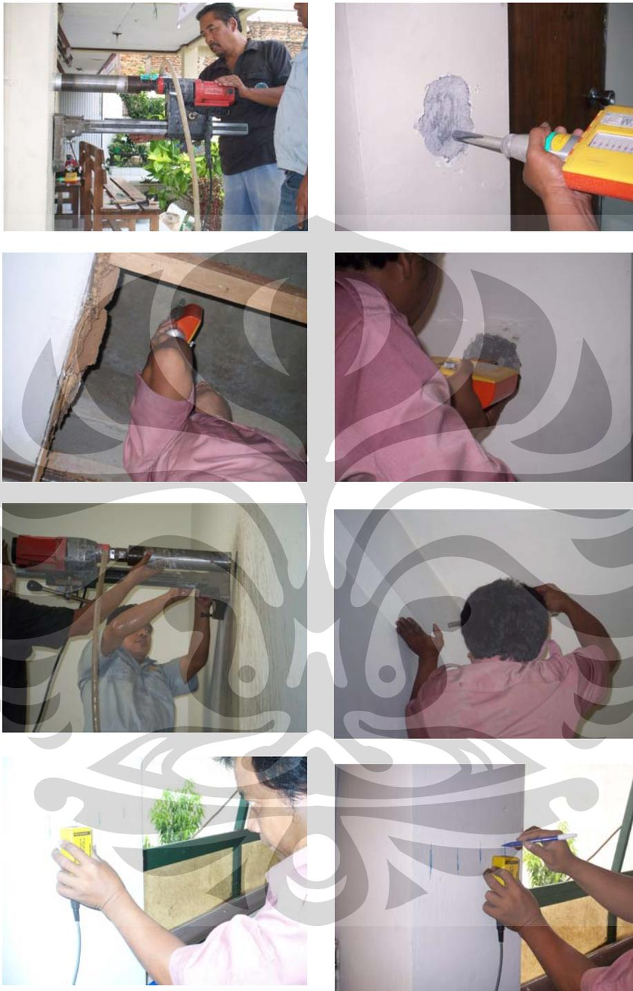
**Gambar 4.4** Foto Pengambilan Sempel Dan Pengujian Mutu Beton di Lapangan
