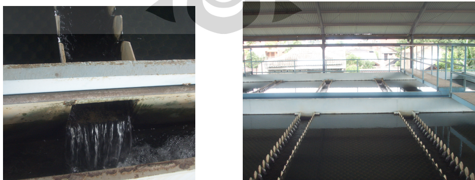
Gambar 3.6 Foto lapangan unit Sedimentasi
