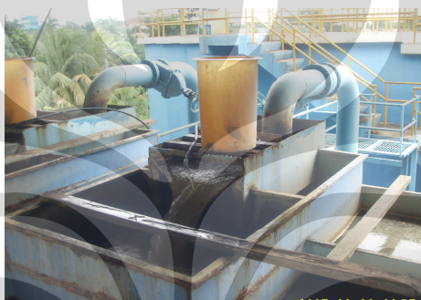
Gambar 3.3 Foto Lapangan Unit Koagulasi
