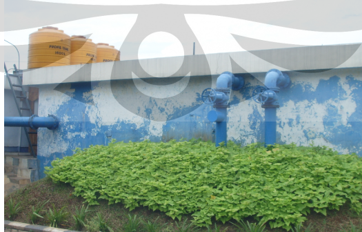
Gambar 3.10 Foto lapangan unit Reservoir
