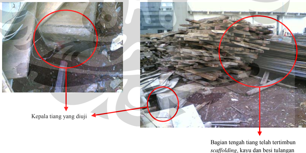
Gambar 1 Kondisi Tiang yang Diuji
