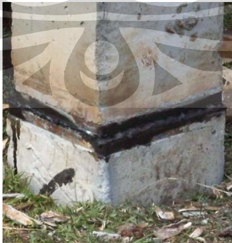
Gambar 4.1 Sambungan pada Tiang
