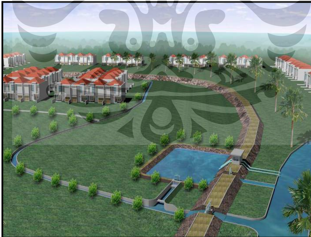
Gambar 5.19. Ilustrasi kombinasi kolam retensi dengan rumah pompa
