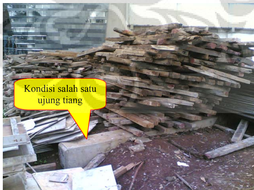
Gambar 4.379 Kondisi salah satu ujung tiang pancang
