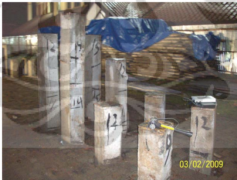
Gambar 3.1 Pemancangan Grup Tiang
