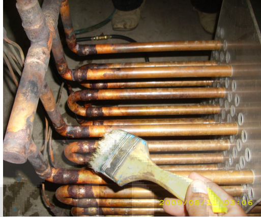
Gambar 2.30 test kebocoran menggunakan metode gelembung
