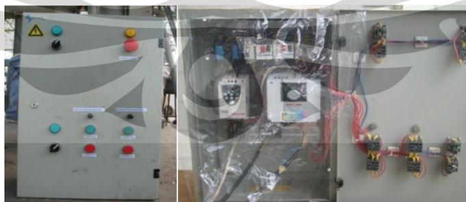
Gambar 3.10 Control panel yang Digunakan untuk Feeder dan Blower
