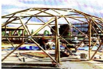
Gambar 2.31. Struktur rangka Bambu dengan Baja
