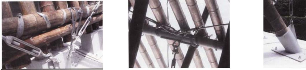
Gambar 2.38. Sambungan Ikat Bambu
