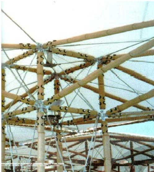
Simon Velez membuat struktur dari material bambu yang terdiri dari batang bambu yang dijadikan dalam 4 sambungan sebagai simpul yang saling dihubungkan dan hanya satu batang yang berhubungan langsung dengan kolom yang kemudian menyalurkan beban kebawah. Setiap batang menahan bebannya masing-masing yang kemudian disalurkan kepusat simpul dari sambungan.
