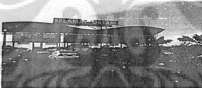
Gambar 5.8 :Pintu gerbang utama (Toll gate) masuk Bandar Udara Sumber : Data primer Bandara Internasional Sultan Hasanuddin
