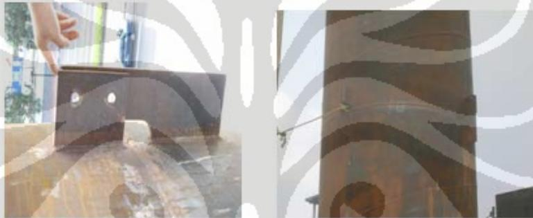
Gambar 4.7. *Gusset & temporary plate* dan Sambungan Kolom *Infill*
