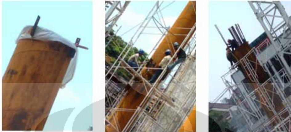
Gambar 4.6. Pekerjaan Sambungan Kolom *Infill*
