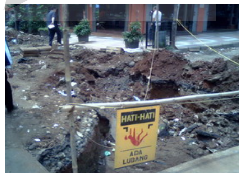
Gambar 4.15 Pekerjaan Saluran pada Jln. Melawai 9
