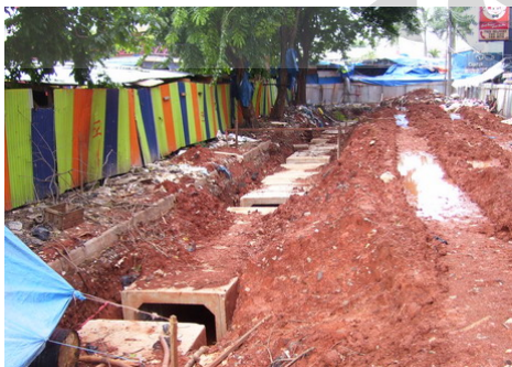
Gambar 4.8 Pekerjaan Saluran pada Jln. Melawai 4
