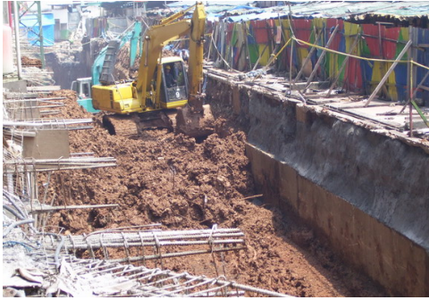
Gambar 4.4 Pekerjaan Tanah Berbatasan Langsung dengan Jln. Melawai 1
