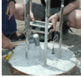
Gambar 2.6 Proses Uji Integritas Tiang menggunakan Pile Integrity Test (PIT)
