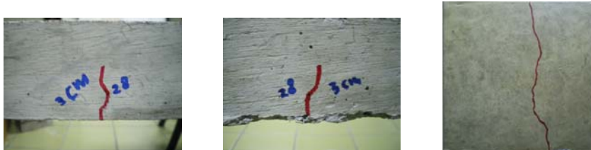
Gambar 4.45. Pelat mengalami keretakan pada pukulan ke 28 dengan panjang retak 3 cm
