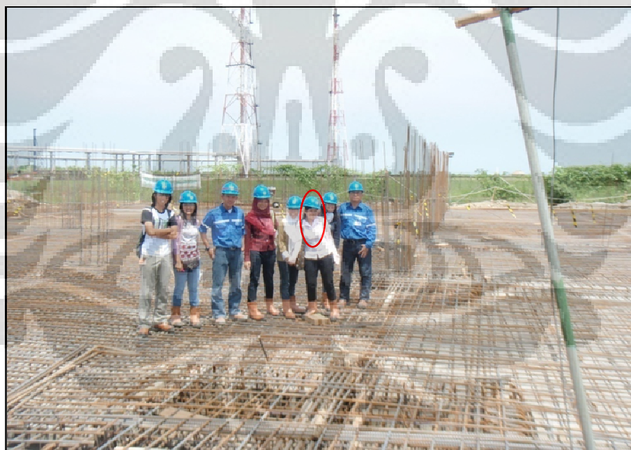
Gambar 3.5. Proses Pembangunan pada Proyek ABC
