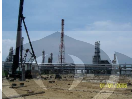
Gambar 3.3. Pemancangan pondasi
