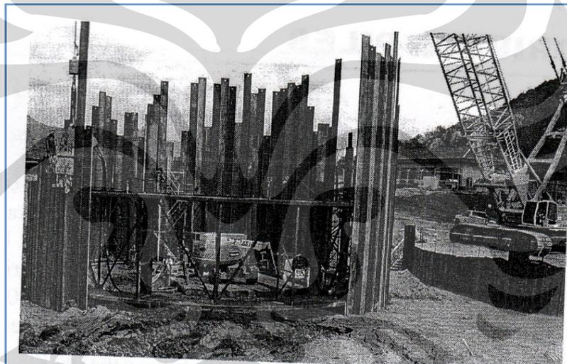
Gambar 2.14. Penggunaan *templates* lingkaran pada *tiang* baja dengan *hammer vibratory*
