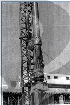
Gambar 2.7. Alat *Diesel Hammer*
