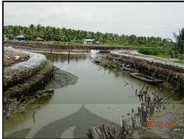
Gambar 4.8 Dinding turap pada kanal
