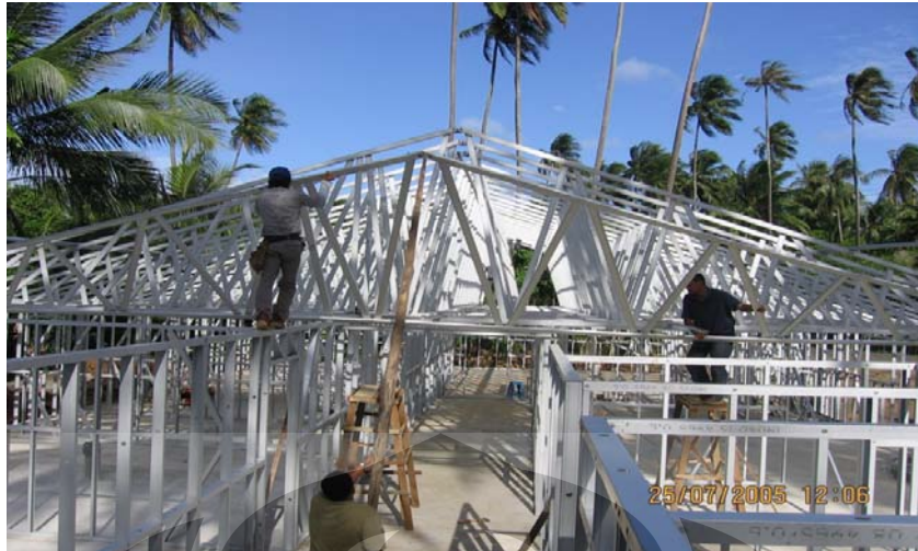
Gambar 4.12. Proses mendirikan kuda – kuda rangka atap baja ringan
