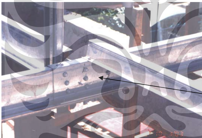
Gambar 2.22. Bentuk Sambungan Baja Ringan
