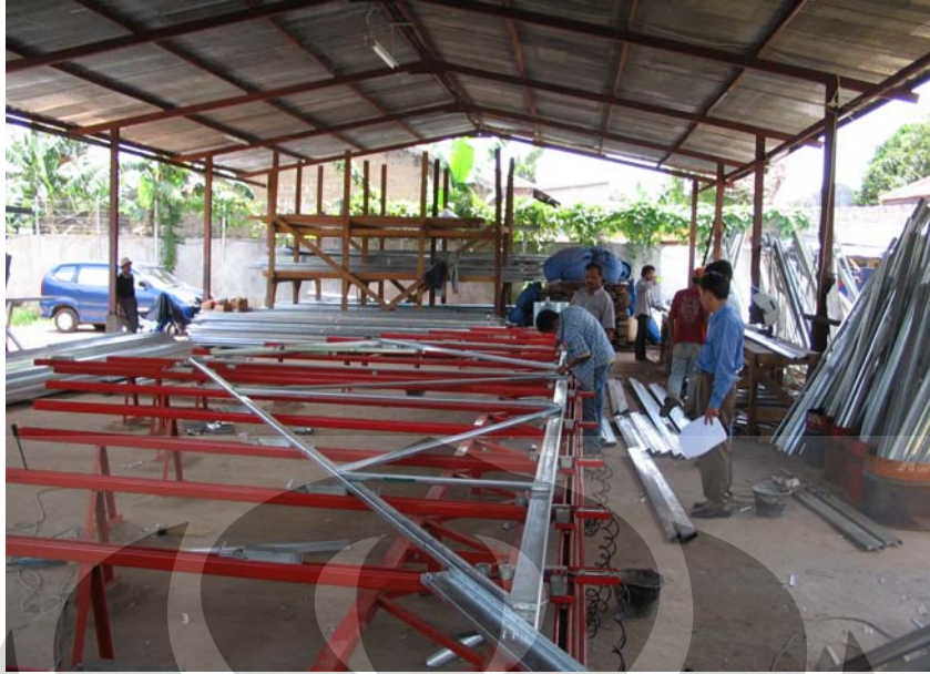
Gambar 4.11. Proses perakitan kuda – kuda rangka atap baja ringan di pabrik
