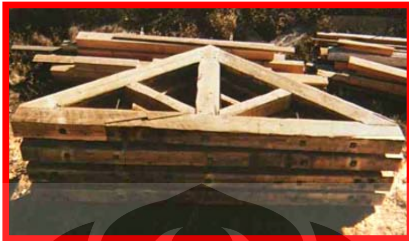
Gambar 4.7. Kuda – kuda rangka atap kayu konvensional yang sudah dirakit
