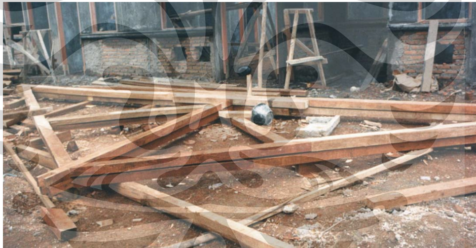
Gambar 4.6. Proses perakitan kuda – kuda rangka atap kayu konvensional
