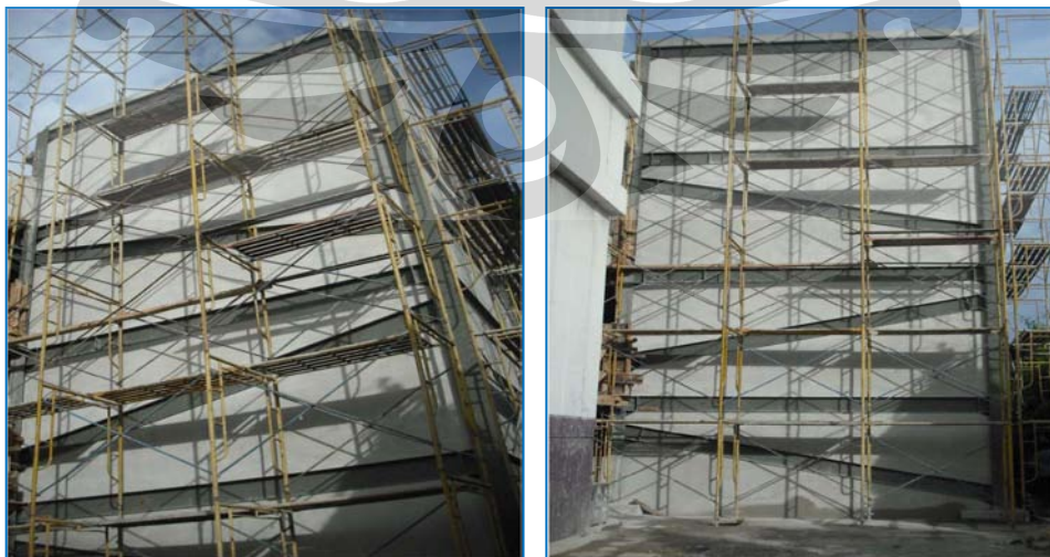
Gambar 4.13 Ruang Tangga Gedung Parkir Roda 2
