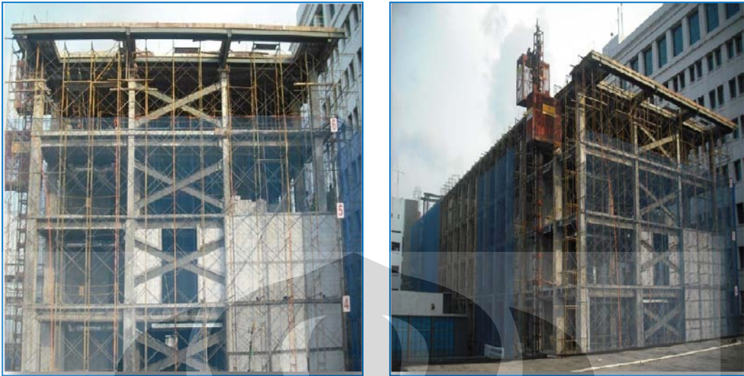
Gambar 4.8 Kondisi eksisting Gedung 4
