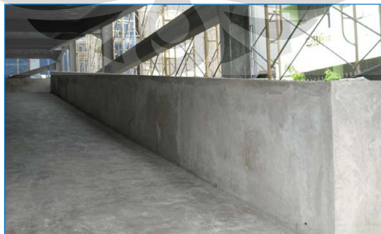
Gambar 4.16 Ramp Gedung Parkir Roda 2 (naik menuju lantai 3)
