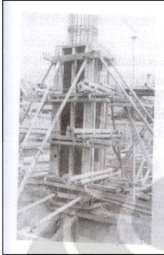
Gambar 2.12: Cetakan kolom dari multiplex phenol
