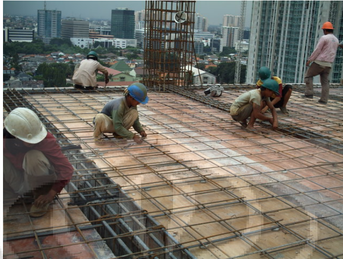
Gambar 2.23: Area kerja (balok & pelat) siap cor setelah pemasangan bekisting dan pembesian.
