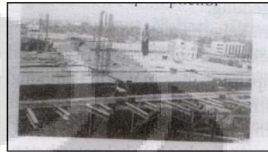
Gambar 2.14: Cetakan balok dari multiplex phenol
