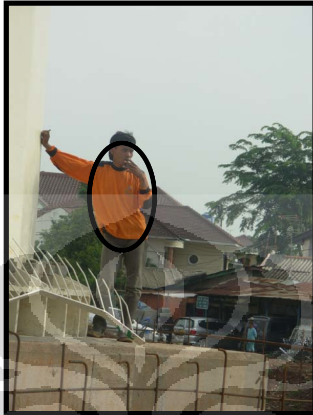
Gambar 5.4. Pekerja yang Merokok Bukan pada Tempatnya
