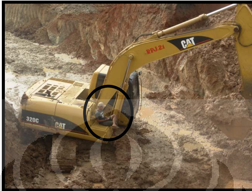
Gambar 5.1. Pekerja Bermain Handphone Saat Jam Bekerja di Excavator
