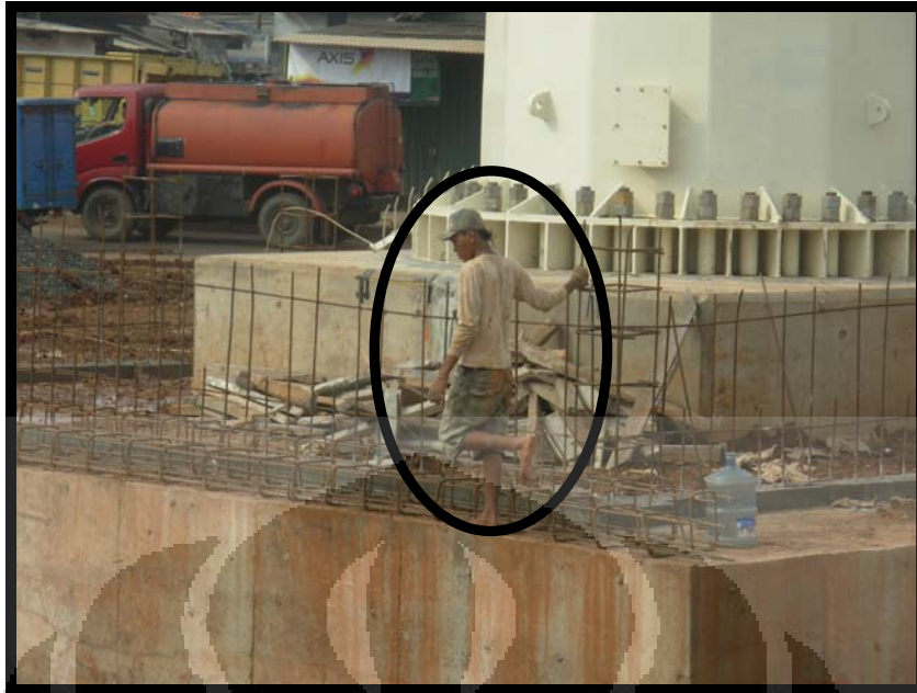
Gambar 5.2. Pekerja Melewati Jalan yang Seharusnya Tidak Dilewati Sumber: Dokumentasi Pribadi (23 Desember 2009, Pukul 15.00-17.00)
