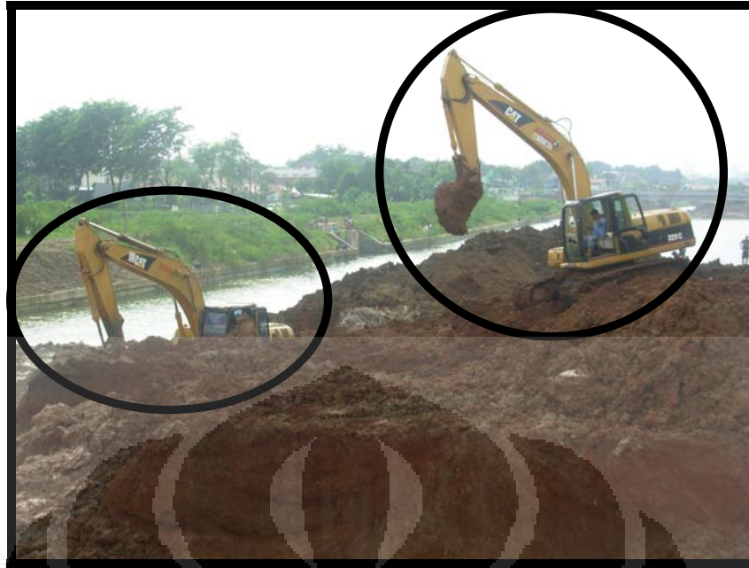
Gambar 5.5. Pekerja Yang Menggunakan Excavator Dengan Aman
