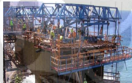
Install traveler pada tiang pier
