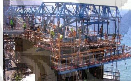
Install traveler pada tiang pier
