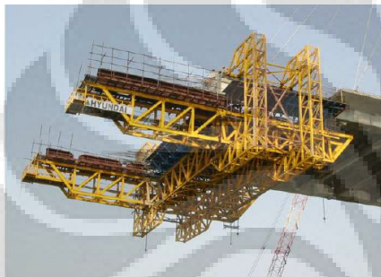
Gambar persiapan cor balok
