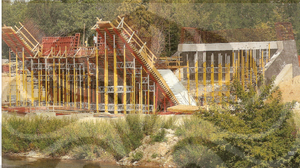
Gambar 5.12 acuan dan perancah bagian kepala jembatan
