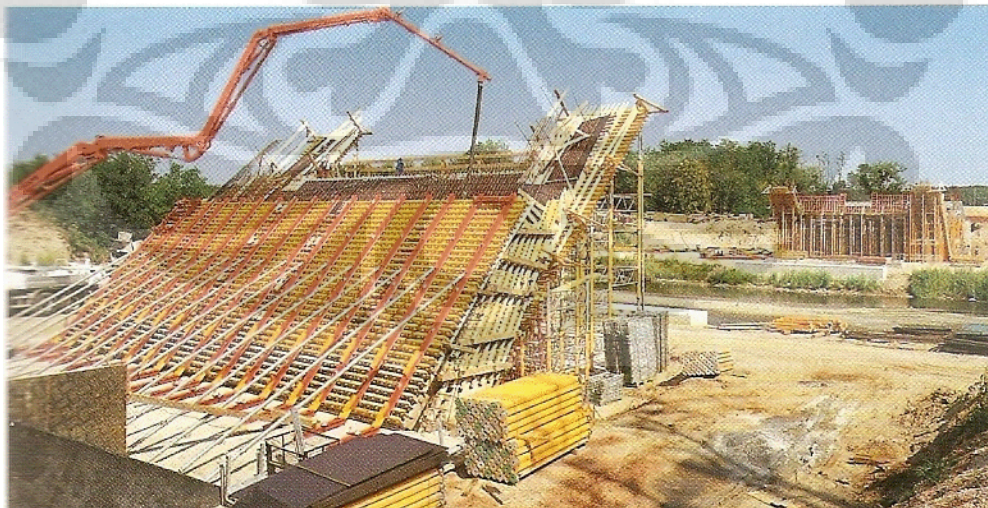
Gambar 5.13 pengecoran bagian kepala jembatan
