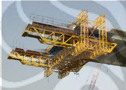
Gambar persiapan cor balok
