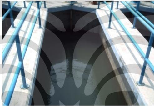
Gambar 4.12. Unit filtrasi
