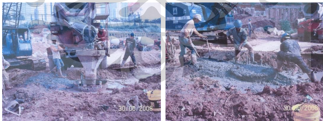
Gambar 4.6. Proses Pengecoran Lubang Bor (dari Dokumentasi Konstruksi TP-03/BP 16)
