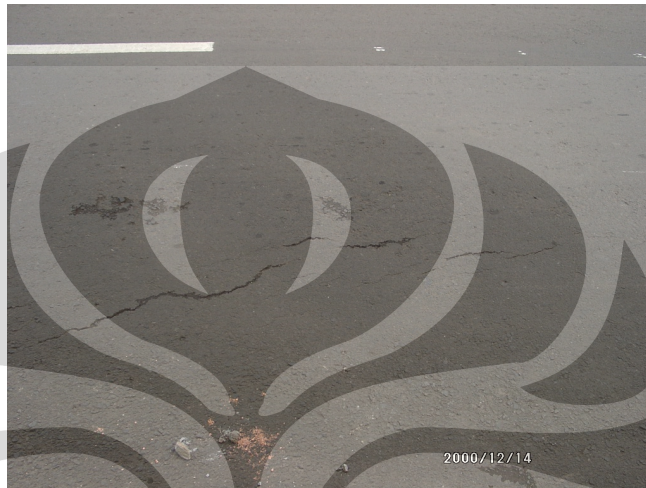
Gambar 2. 2. Retak Garis pada Perkerasan Aspal
