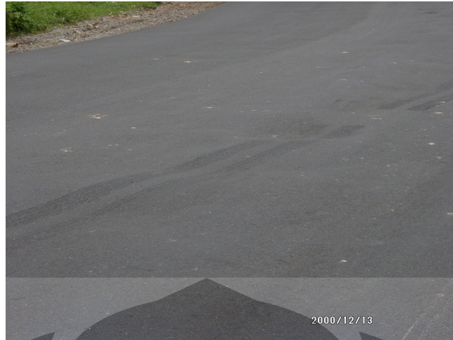
Gambar 2. 8. Sungkur pada Perkerasan Aspal
