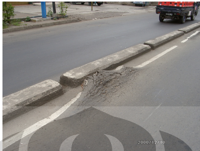
Gambar 2. 6. Amblas pada Perkerasan Aspal
