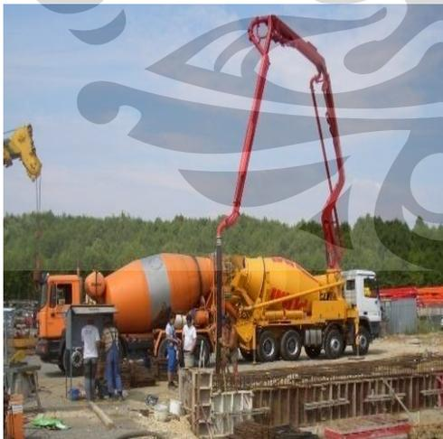
**Gambar 3.2** Proses Secara *Dry Mix* di *Truck Mixer*
