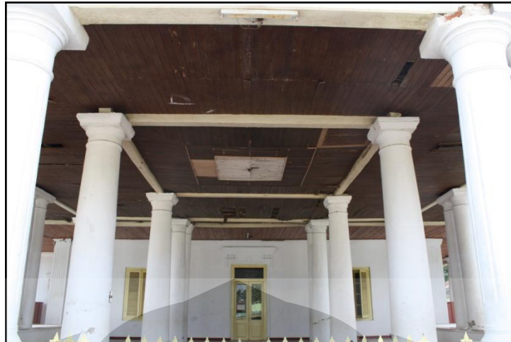
Gambar 4.3 Kolom Teras Tengah dan Beberapa Bukaannya (Pintu dan Jendela)
