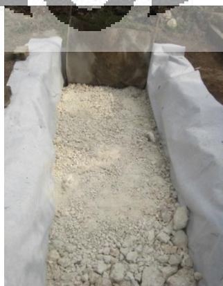
Gambar 4.4. Lapisan kapur sebelum dipadatkan
