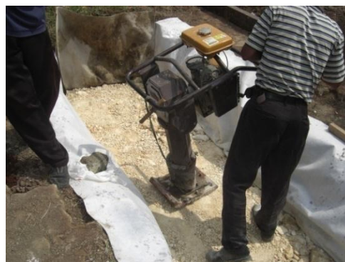
Gambar 4.8. Pemadatan tanah dengan menggunakan stamper
