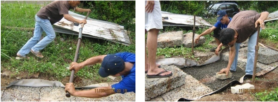
Gambar 4.21. Pemasangan Angkur dan Setelah ankur terpasang dengan baik dikedua sisi benda uji
