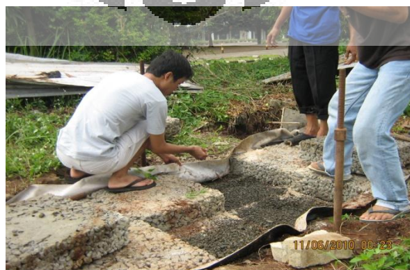
Gambar 4.22. Pembongkaran lapisan pervious concrete
