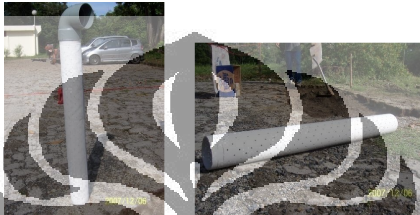
Gambar 3.16. Pipa berlubang dibungkus dengan kain kasa dan disambung dengan knee
