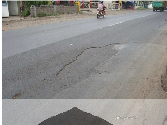
Gambar 2.13. Delaminasi
