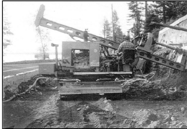
Gambar 2.26. Metode Pengeboran Rotary
