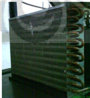
Gambar 3.3.4. Kondenser sistem pendingin
