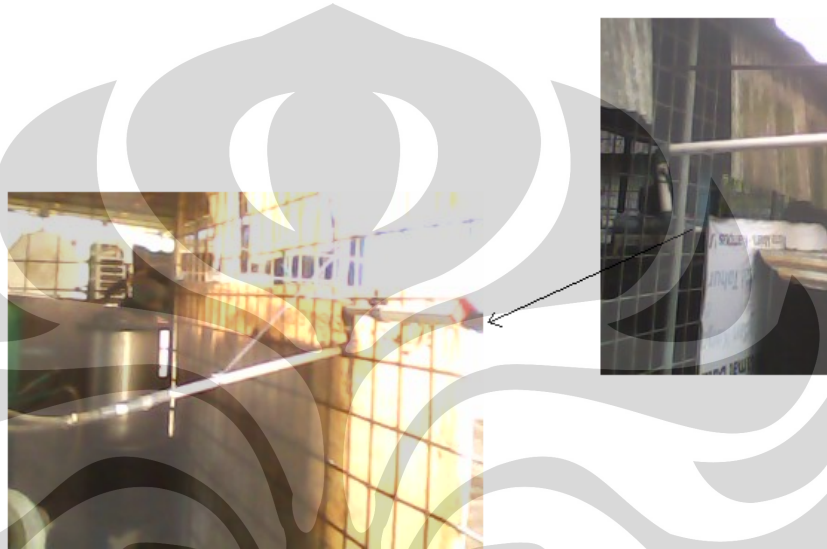
Gambar 3.2.4.2 Sistem Pemipaan air masuk venturi scrubber
